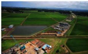
● 調査区全景（市道区、南から）
