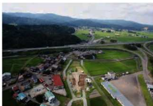
● 調査区全景（南から）
