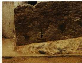
南壁石西側の梃子穴(矢印の部分)
