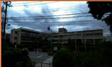
①外観全景 東面(正面)
