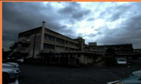
②外観全景 西面(背面)
