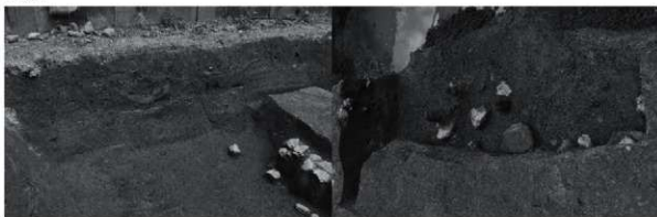
1. A-1 北西壁面土層（南から）
