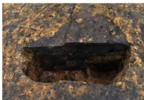
第 2 号掘立柱建物跡 P6 土層断面
