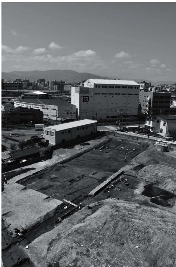
1区全景（北東から・2020年4月）
