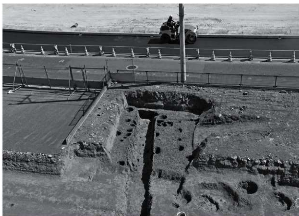
II区SD05 拡張区 (西から)
