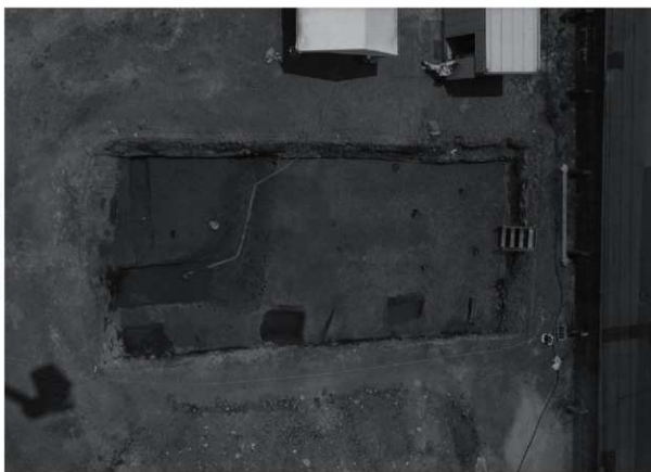
IV区全景 (東から)
