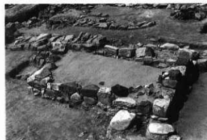
建物基礎156 (南東から)
