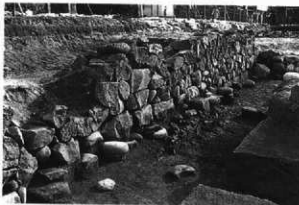
石垣28 (北西から)
