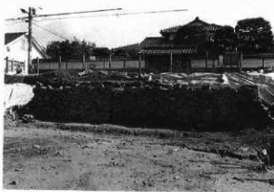
石垣55北半 (西から)
