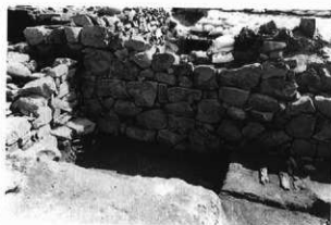
石垣7(3-A区)(南西から)
