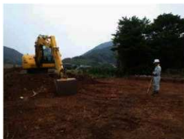
写真1 重機による表土除去
