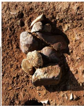
SK22 礎充填状況 (南から)
