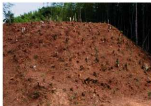
西側斜面調査前状況（北西から）
