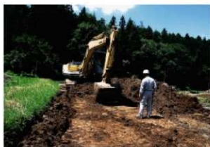
重機による表土除去
