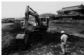
重機による表土除去作業
