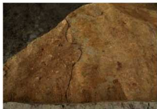
土壘粘土貼り付け状況
