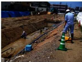
写真3 国土座標杭設置
