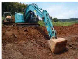
写真1 重機による表土除去
