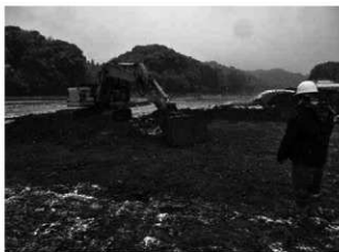
重機による表土除去作業
