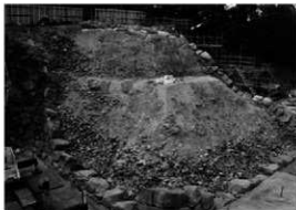
2. 石垣の解体状況 (南東から)
