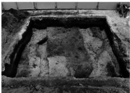
2. 第II区全景 (北から)
