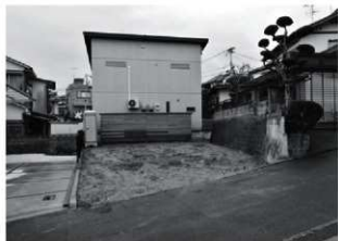
7. 調査前全景 (北から)
