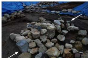
Ph. 19 石積遺構部分①目地A (南より)
