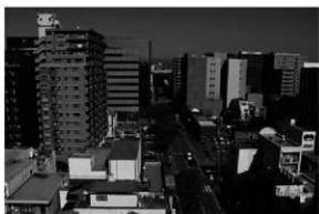
3. 調査区周辺遠景 (北東を望む)
