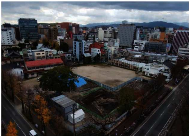
5. 221次調査区全景（北東から）
