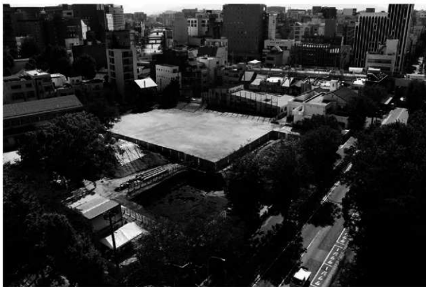
5. 調査区遠景 (北東から)
