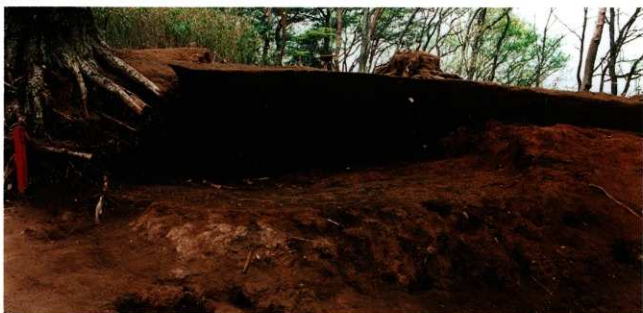
1号遺構土層断面 (2) (東より)
