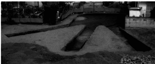
調査範囲完掘状況 (南より)
