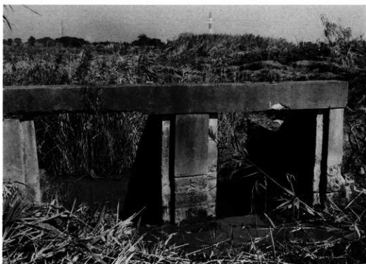
2 かみた堰現状
