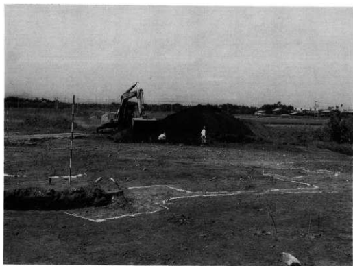
2. 重機による表土剥ぎ風景
