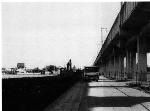
2. 発掘調査状況（重機による表土剥ぎ）
