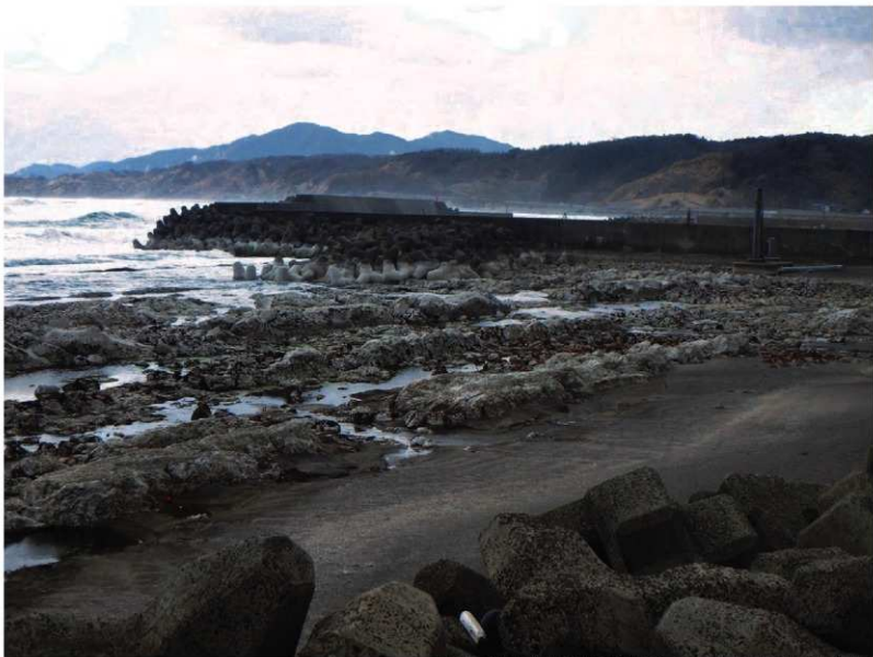
隆起した漁港（石川県輪島市名舟漁港周辺） 2024年3月18日 吾妻俊典氏撮影
