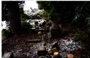
“明泉寺石塔群在地”(県文化財)の倒壊状況(同上)
