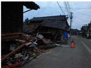
③恋路観光バス付近（能登町松波）震度6強を観測した。建物の壊れ方が一段と著しい。地元消防団が倒壊家屋から住民を救出した。
