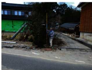
④能登町白丸地区 震度6弱を観測した。車載カメラによるとわずか20秒後に津波襲来。道路の砂は津波堆積物。地上高2.0m付近にビニールなどの浮遊物がある。
