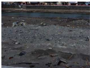
⑥河原田川（輪島市） 右岸堤防から左岸の鳳至町下町を望む。護岸には津波の遡上痕跡を示す泥が付着している。河原には流木等が残る。
