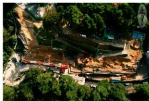
第10図 調査区全景(石垣解体最終段階)
