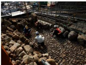
第11図 石垣補強材の施工状況
