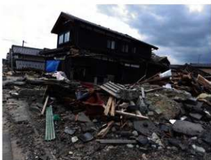
②鶴飼川に面する町並（珠洲市宝立町鶴飼） 鶴飼川の左岸堤防（写真左手側）を越えた津波は1階部分を突き抜けている。流出瓦礫顕著。津波堆積物は硬泥じり。
