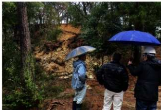
松波城の町指定曲輪が土砂崩れ
