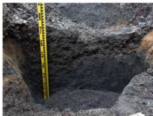
⑥流路断面 深さ1m付近で水が湧きはじめ、天候も雨模様となり、調査は断念した。写真は一部、埋め戻しははじめたところ。
