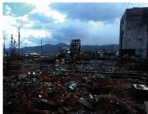
①輪島市輪島朝市（輪島市河井町）18時ころに出火。地震による断水で消火栓が使えず、河原田川から取水することもできなかった。約300戸焼失。
