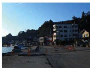
⑥能登小木漁港（能登町小木） 護岸は大きく損傷しているが、明瞭な津波の痕跡は見当たらない。建物裏手は海食崖になっている。
