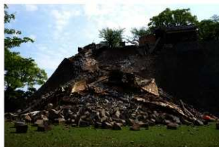
第2図 北十八間櫓崩落状況
