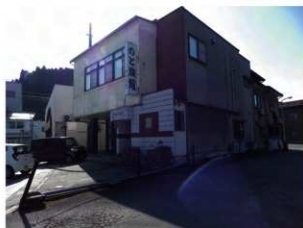
②能登町役場前ののと旅館（能登町宇出津） トイレ・水道未復旧、素泊まり。近くのファミリーマート 能登町宇出津店が営業を再開しており、食料購入。
