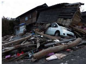
⑥折戸川右岸（珠洲市折戸町） 山田橋のたもとの民家である。津波により1階部分に車や大量の建築部材、プラスチック片が流れ込んでいる。
