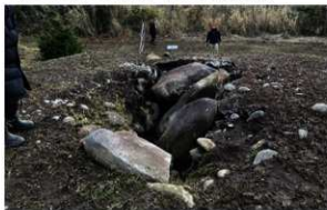
天井石が崩れて落下
