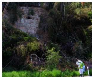
墓室が露呈し、入り口が土砂で埋まる
