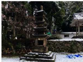
石造五重塔(国重文、室町)上部にずれ(3月10日)
