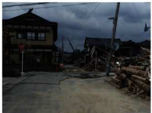
⑤丈六山妙厳寺門前（珠洲市宝立町鶴岡）液状化によりマンホールは突き出し、道路奥の寺の山門は崩落している。路面には津波堆積物の砂が広がっている。
