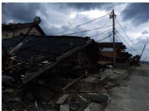
①鶴飼川に面する町並（珠洲市宝立町鶴飼） 妙厳寺山門を東に進んだ鶴飼川堤防角地。建物屋根が敷地から南に倒落し、瓦礫で道路がわからなくなっている。
