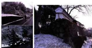
第18図 東日本大震災による被災状況
