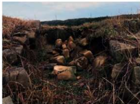
横穴式石室側壁が崩落
