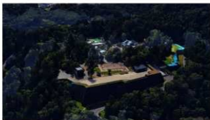
第17図 修復後の本丸北東部石垣(2023年)
