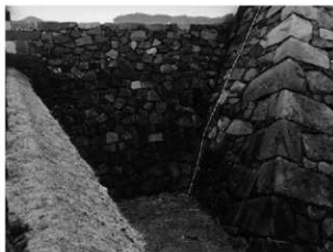
写真2 天守台東面（U62）石垣北部
