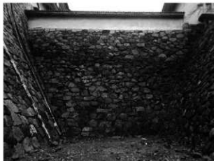
写真5 橋台西面（U 58）石垣
