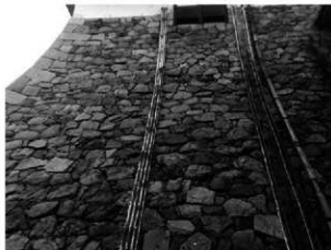
写真3 天守台南面（U59）石垣西部
