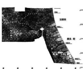
図2 大天守台東面 (U62) の水平方向目地
