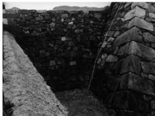
写真4 不明門北面西半（U 63）石垣
