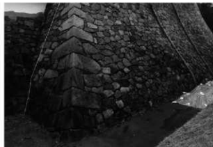
写真1 天守台北面（U61）石垣
