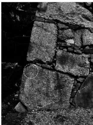
写真3 小天守台南西角/南から
