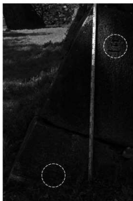
写真5 本丸南東角/東から
