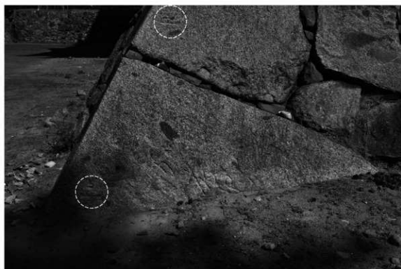
写真2 大天守台南西角／南から
