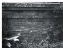
写真13 れんが壁近景
