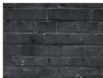
写真10 れんが壁近景
