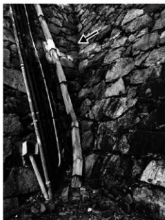
写真2 大天守と橋台西面入隅部 (右：橋台西面、左：大天守南面) 矢印部分までは組み合い、それ以上は大天守が先に築かれる
