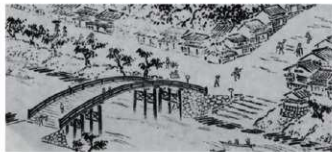
3 小治田之真清水（尾頭橋）ともに橋脚は川の中央を開ける。
