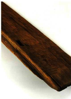
3 桶部倉矧壁板 側面部V字谷形加工
