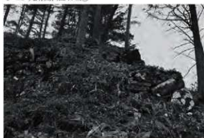
3 二ノ丸石垣⑦、⑧北端部
