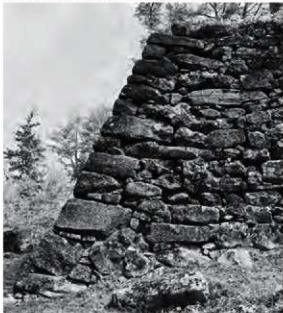
写真 55 石垣⑤西側隅角
