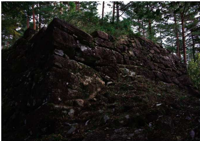
1 三ノ丸隅櫓石垣
