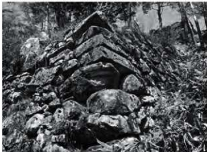
写真 51 石垣⑤と⑥ 出枅形虎口南東隅角
