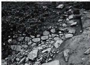
写真 49 石垣⑤ 石垣⑥との接点近くの石垣
