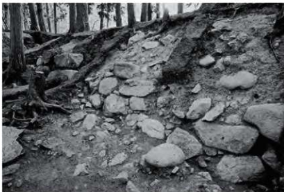
写真 68 古川城で検出された、金森時代の石垣
