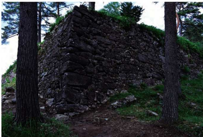
2 本丸外曲輪石垣西南隅
