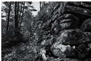
1 出桥形虎口石垣㊟
