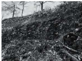
写真 44 石垣㉙ 三ノ丸西面北側石垣
