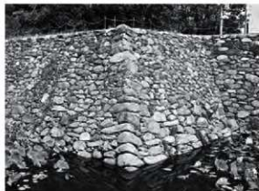
写真 62 中津城三ノ丸南面隅角部
