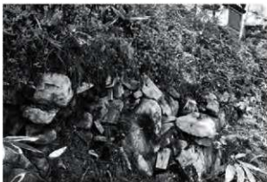
写真76 二ノ丸北辺の小石材を用いた石垣
