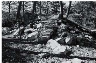
写真 43 石垣㉔～㉕ 三ノ丸隅槽台石垣
