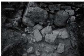
6 第9fレンチ 石垣①根石掘え方(南から)
