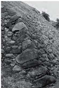
写真 64 名護屋城船手門北西下
