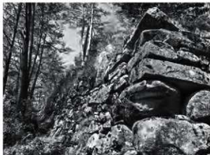
写真 52 石垣⑥ 出枅形虎口南東隅角から
