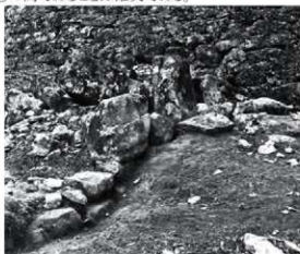
写真 54 石垣⑧と⑨ 南西より
