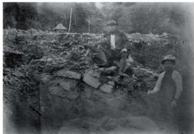
写真 21 五阿弥池工事中に見えられた石垣(角竹文庫)
