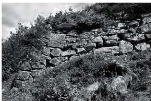
写真 30 石垣⑬ 本丸内曲輪西北端部
