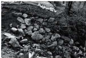
3 出桥形虎口石垣㊟
