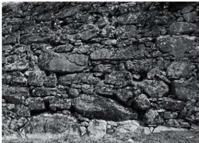
写真67 本丸外曲輪南面(石垣⑤)の築石部
