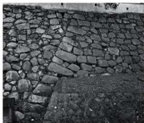
写真 60 中津城 埋め殺された黒田期石垣
