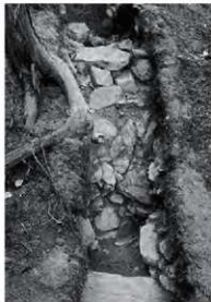
写真 69 前段階の石垣
