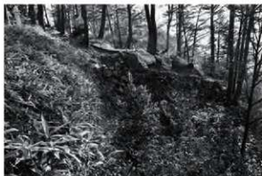
2 出桥形虎口石垣㊟
