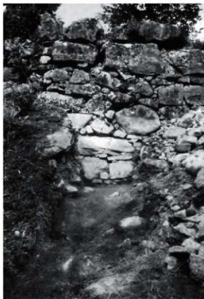
5 第1トレンチ 本丸内曲輪石垣⑤(南から)
