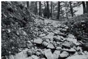
7 第4レンチ 破城の状況(西から)
