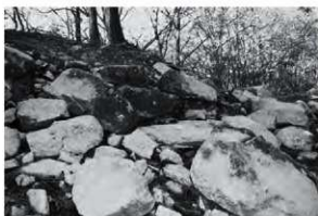
2 三ノ丸陣槽 石垣(南東から)
