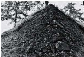
写真 72 石垣造りの中心部
