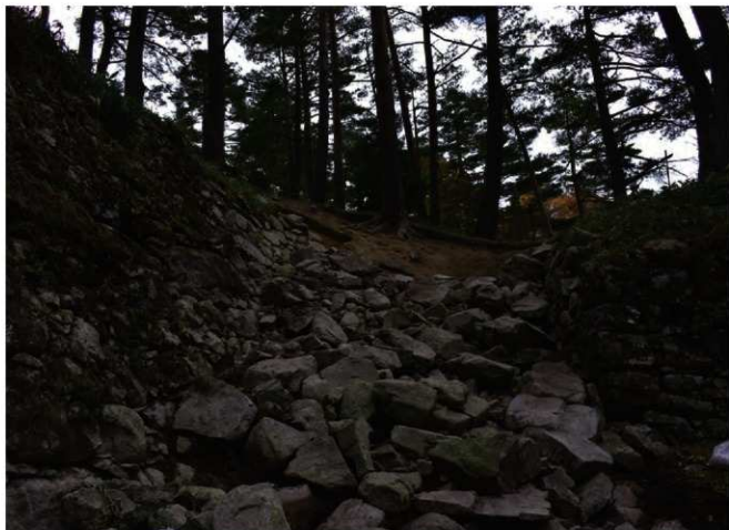
1 破城による落石で塞がれた出柙形虎口へ向かう通路
