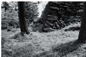
1 第9fレンチ 調査前(南から)
