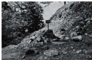
8 埋門と石垣㊸、㊹(南西から)
