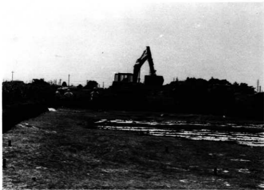
1. 調査風景（重機による表土剥ぎ）
