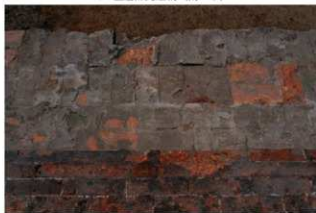
4. 煉瓦遺構A細部 (北から)
