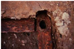
6. SE01井桁北東隅缺穴 (南から)
