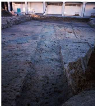
1. S002完掘 (北から)
