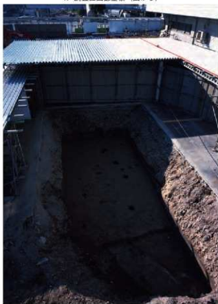
2. 調査区東部全景（東から）
