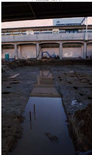
3. S002滞水状況 (北から)
