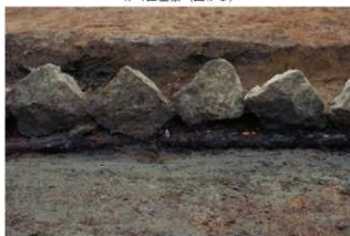
4. 1区SX01護岸石組み下脚木 (西から)
