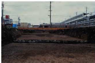
2. 1区SX01護岸石組み (西から)
