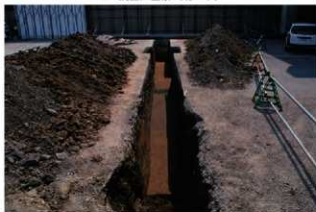
3. 下水道部分先行 (西から)
