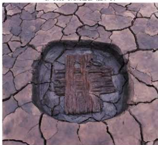
4. SB05-SP215礎板 (北から)
