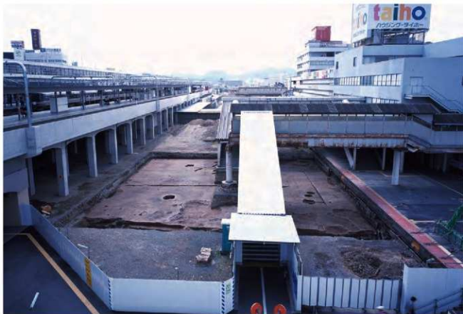
1. 調査区東部全景 (東から)
