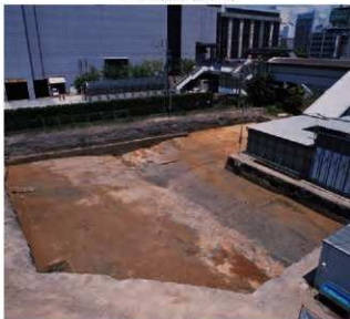
3. SR01全景 (南西から)
