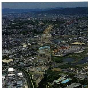
第二京阪道路の発掘調査（寝屋川市域）
