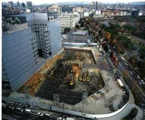
大坂城跡 Ⅱ期調査地全景
