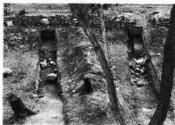
第9図 第1・2トレンチ(東より)
