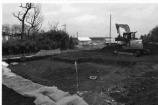
西富田新田遺跡 B 地点表土除去作業風景 南東から
