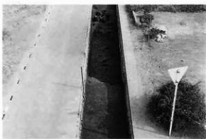
林9号墳B地点 周堀検出状況 [北西から]
