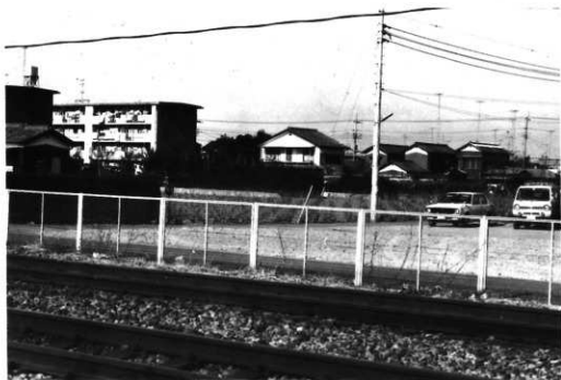
1. 近八幡支群現状（南より北を望む、手前は高崎本線）
