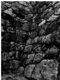
写真1 大天守と橋台東面入隅部 (右：大天守南面、左：橋台東面) すべて大天守南面に先に築かれる
