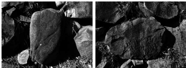
図3 築石部における自然面（左）・断面（右）（135N石垣）
