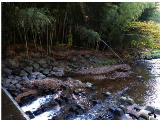
口絵 12 長久手市猪鼻堰跡残石群 左岸 (北西から)
