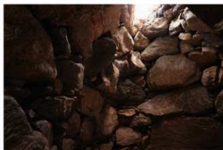
(1) 12号墳玄室左側壁上部（南から）
