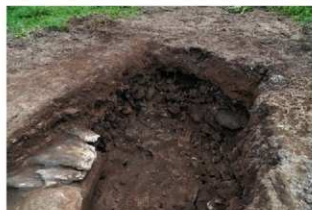
(5) 148号墳玄室奥壁破壊状況（西から）
