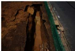
第10図 SD4632完掘状況 (南から)
