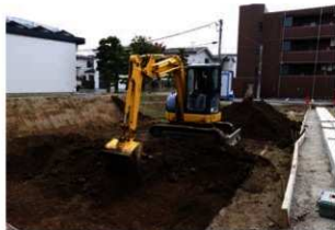
第21図 表土剥ぎ風景（北西から）
