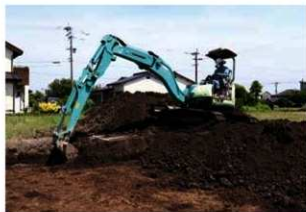
第3図 表土剥ぎ風景（北西から）
