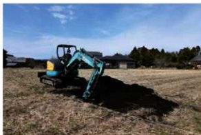
6. 埋め戻し状況
