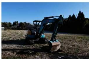
2. 表土除去状況
