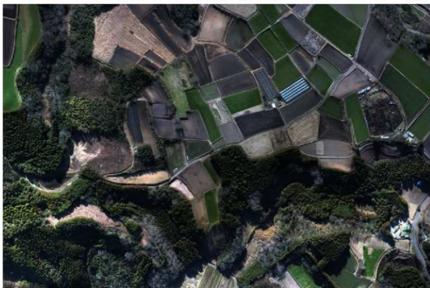
調査前状況 垂直写真
