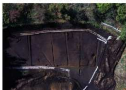
3区 アカホヤ火山灰下位調査状況 垂直から
