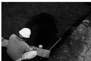
SC7 調査状況
