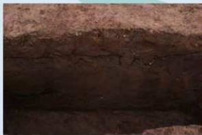
路面の硬化層の断面
