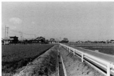
排水路（蛭川地区）東から 47
