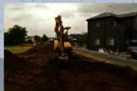
作業風景(西浦遺跡27区)
