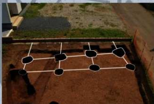
1号掘立柱建物跡 (北から撮影)
