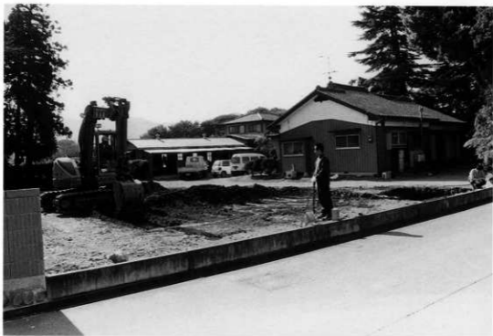
1 表土除去風景（北東から）
