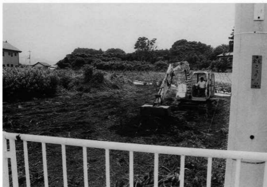
1 飯玉地区D地点 表土除去作業（東から）
