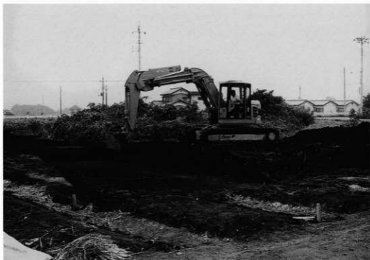
1 飯玉地区C地点 表土除去作業（北西から）
